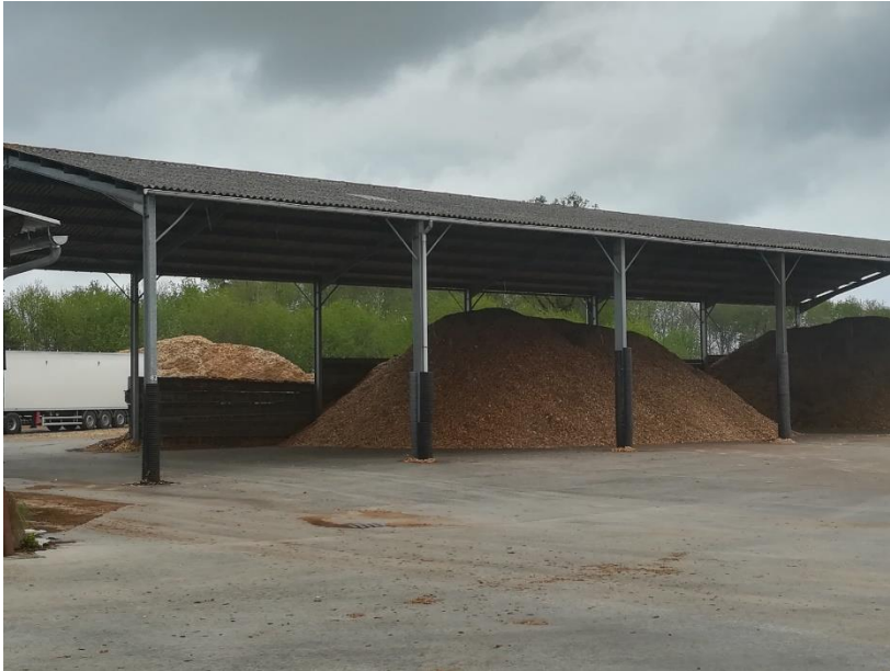
Photo 17 Stockage sous abri de plaquettes
